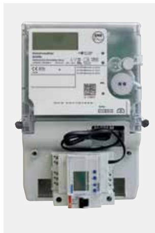
Montage unter dem Klemmendeckel des EDL21-Zählers
